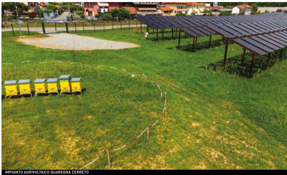
IMPIANTO AGRIVOLTAICO QUAREGNA CERRETO
